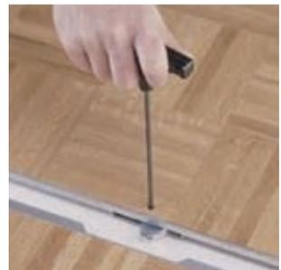
六角レンチでジョイント部分を固定するだけで設置ができます。
